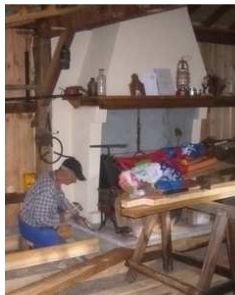
Bernard Darmuzey a même bâti une cheminée, construite dans l'esprit d'autrefois. Convivial, non?
