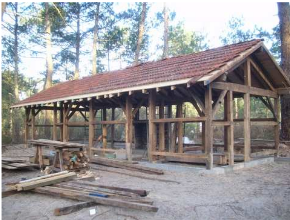
La cabane de Cugnes en cours de construction.
